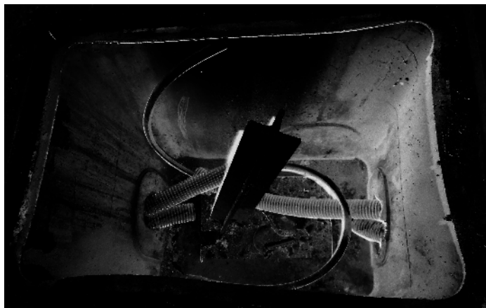
Conduttore di terra lasciato disconnesso per anni, in attesa di collegarlo "domani"
